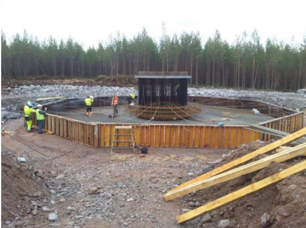
Kuva 20. Tuulivoimalatyömaa (kuva Honkajoelta, kuva Taaleritehtaan)
